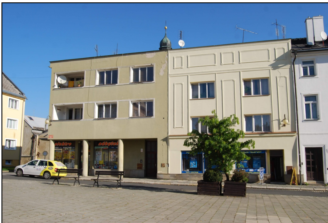
Současný stav, novostavba objektu (č.p. 198) ze 60. let 20. stol.
