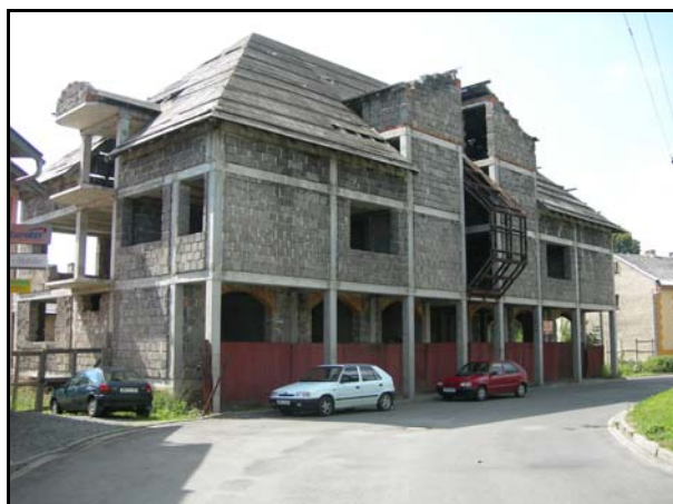
Nedokončená novostavba komerčního objektu, která významným způsobem narušuje nejen úroveň zástavby, ale i dálkové pohledové souvislosti s historickou zástavbou, půdorys objektu v hrubých rysech odpovídá objektu zakreslenému v katastrální mapě ze 30. let 20. století.
