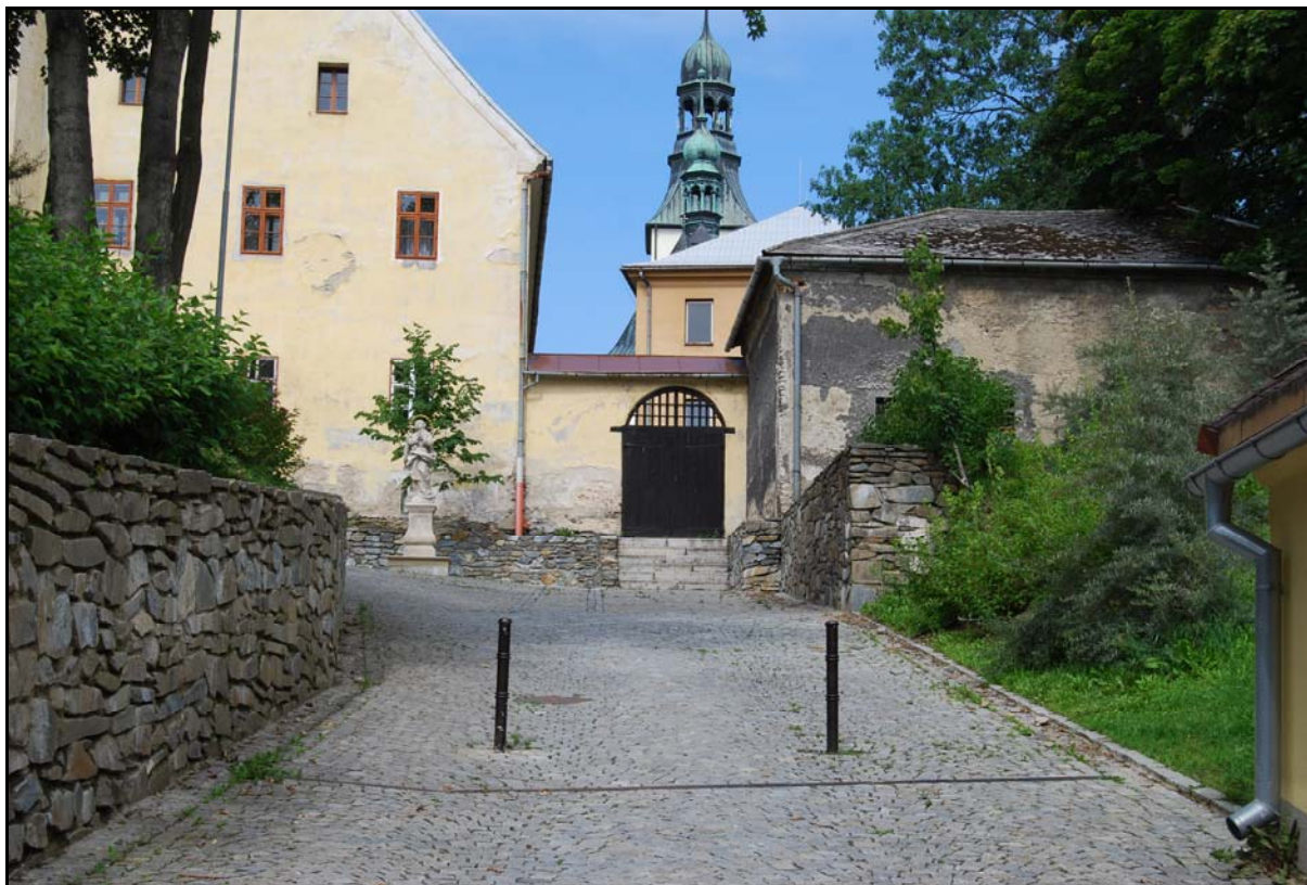
Celková revitalizace ulice Horní dokončená v roce 2010
