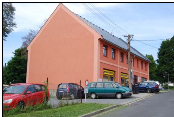
Novostavba z roku 2008 na levé straně konce ulice Husovy, v tomto prostoru se měl do 70. let nalézat tzv. „Burgetův statek“.
