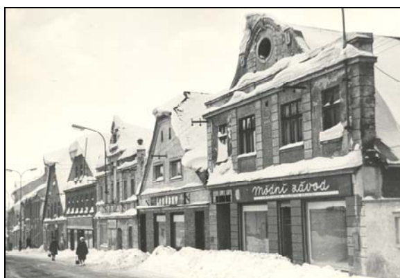
Pravá strana ulice Radniční před demolicí (MMR)
