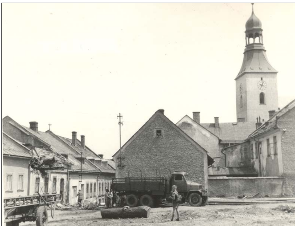
Demolice objektů na Jungmanově ulici, 1960 (MMR)
